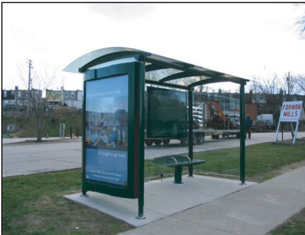
Abribus peint en noir anti-graffiti (structure d'aluminium et banc en acier)
